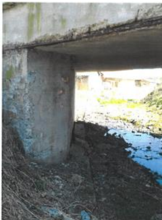
Obrázok 44 Rozpad ochrany základov opôr
